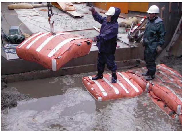
液状化地盤での擁壁下部の地盤補強例
