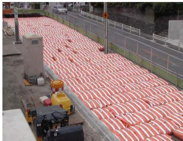
道路の地盤補強及び振動低減の施工例
