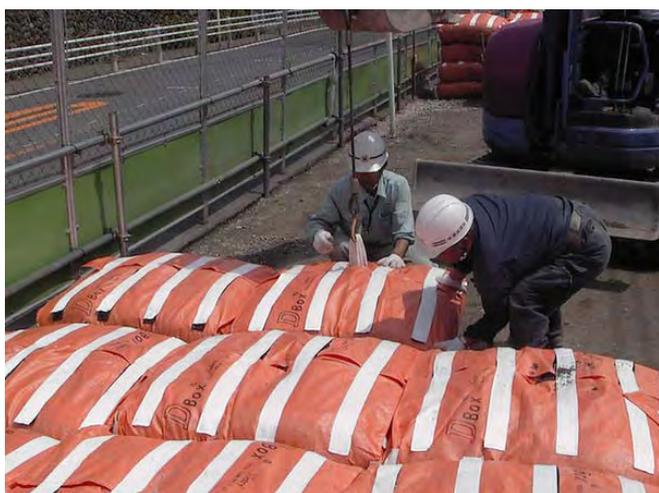
3) 重機やクレーンで吊上げ敷設箇所に設置
